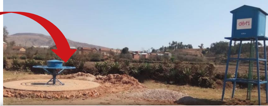
La pompe à manège et son château d'eau pour le stockage
